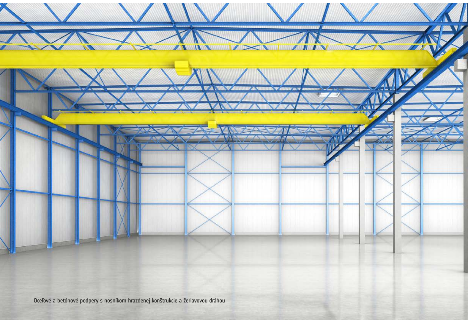
Oceľovo-betónové podpery s nosníkom hrazdenej konštrukcie
